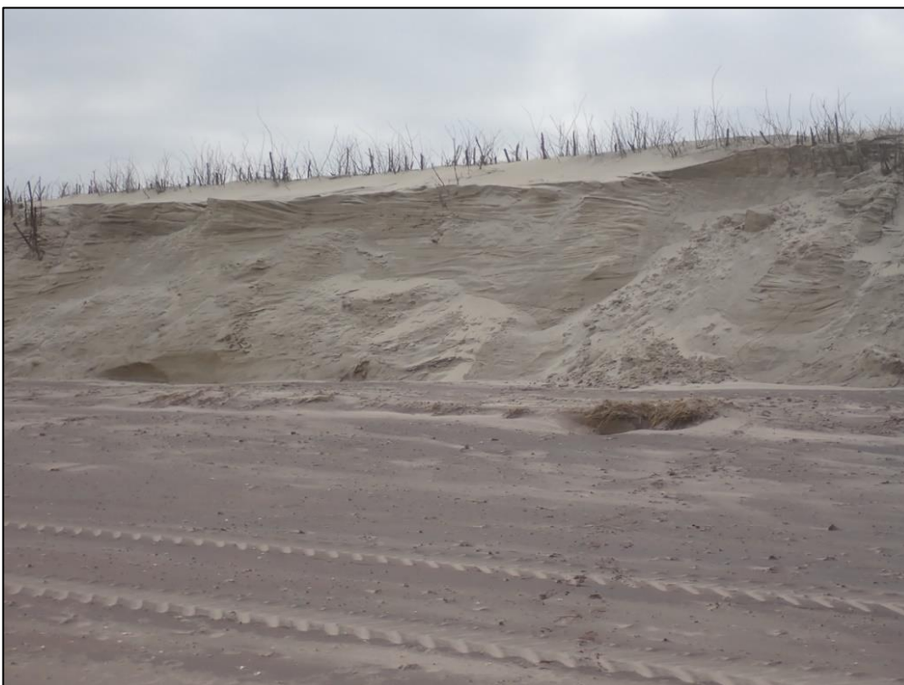
Abbildung 2: Die Abbruchkante reicht bis an die Buschzäune in der Weißdüne heran
