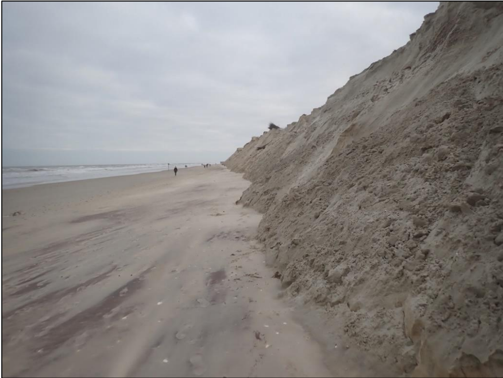
Abbildung 5: Abbruchkante im Westen des Plangebietes. Bei höheren Wasserständen wird die Abbruchkante vom Wasser erreicht
