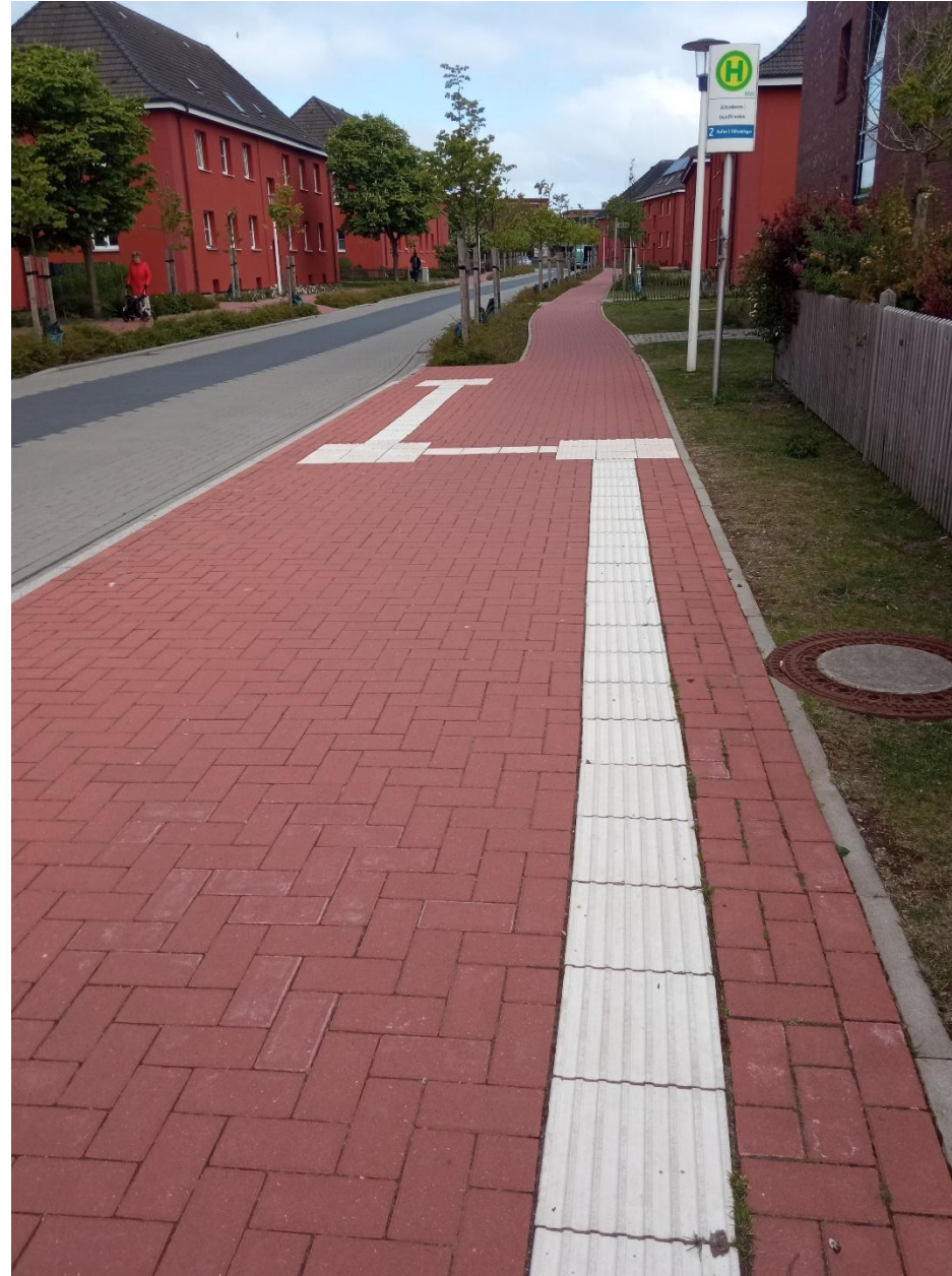
Sanierung der Feldhausenstraße
