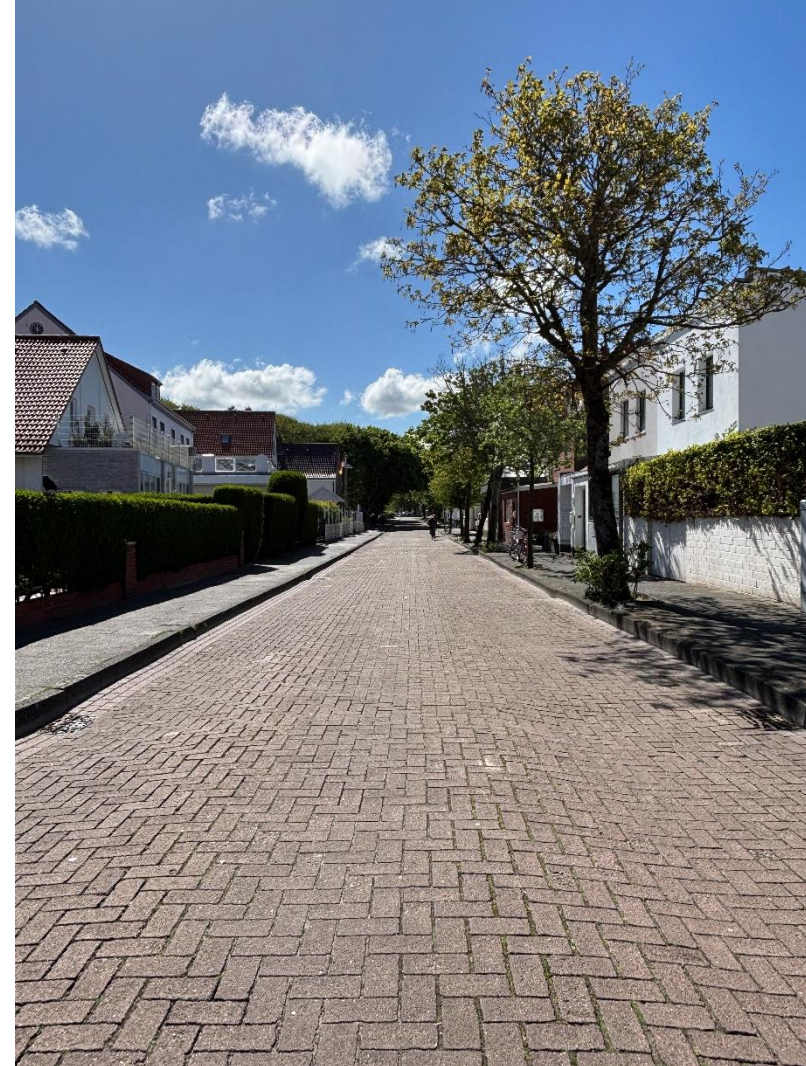
Sanierung der Feldhausenstraße
