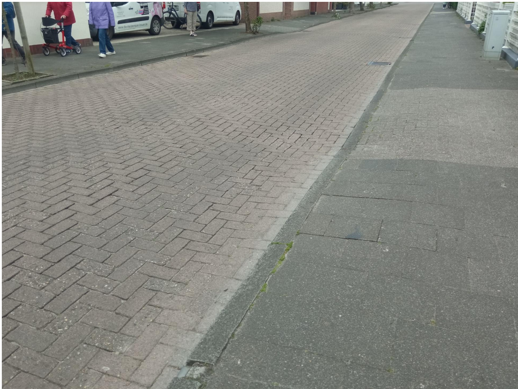
Sanierung der Feldhausenstraße
