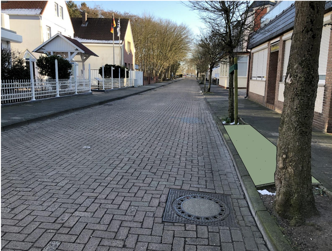
Sanierung der Feldhausenstraße
